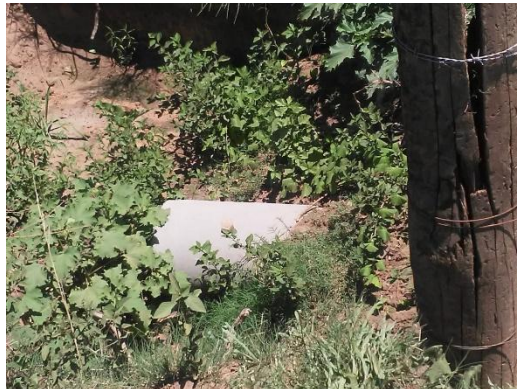
Figura 6: tubos de esgoto direto no arroio Carolina
